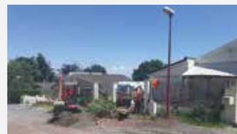
Chemin des Gîtes, les travaux de renouvellement des réseaux secs et humides et de la voirie sont en cours de réalisation. A terme, ils permettront de séparer les eaux pluviales et les eaux usées, grâce à un réseau d'assainissement remis à neuf. Les réseaux secs (électricité...) et la voirie seront également refaits.
