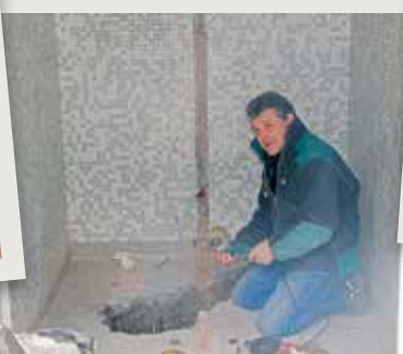
Réfection totale des sanitaires publics du Parc thermal
